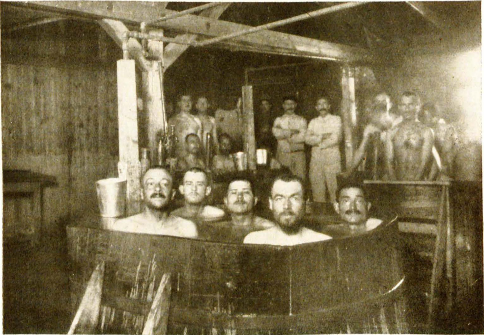
OBEN: FAHRBARE DESINFEKTIONSAPPARATE, LAGER KÖNIGSBRÜCK. — UNTEN: GEFANGENE WERDEN MIT EINER DESINFEKTIONS-LÖSUNG ENTSEUCHT, ORT GÜSTROW (SEITE 49)
