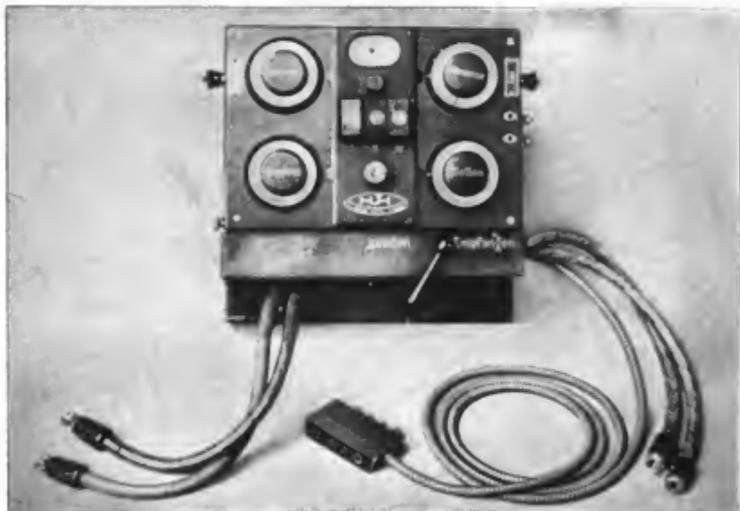
Abb. 163. Firma Dr. E. F. Huth; Erster Flugzeugempfanger mit angebaurem Sende-Empfangsumschalter, 1915/16.
