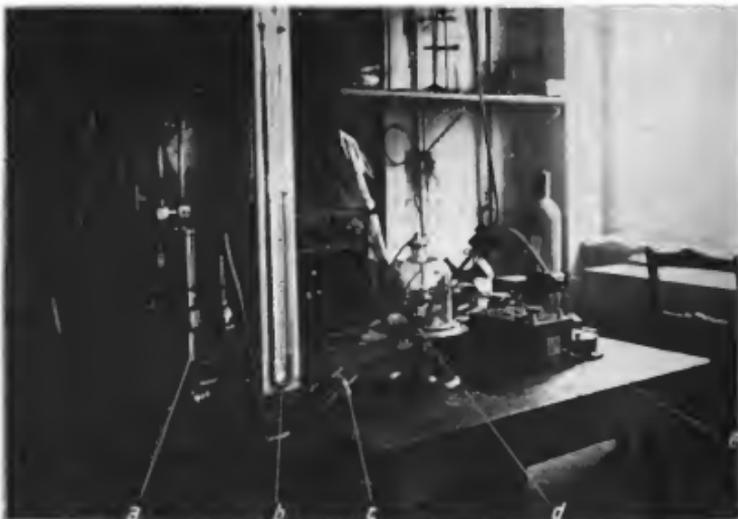
Abb. 303. Untersuchung der Funkenstrecke im Vakuum, a — Öl-Luftpumpe, b — Manometer, c — Dreiweghahn, d — Rezipient mit Funkenstrecke, e — Wellenmesser.
