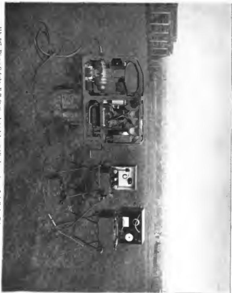
Abb. 247. Flieger-Geräte-F. T.-Station betriebsbereit (die Apparatur außerhalb des Fahrzeuges) aufgebaut.
