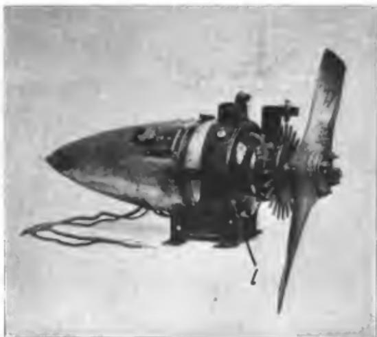
Abb. 314. Französischer Sender mit rotierender Funkenstrecke, Wechselstrommaschine.
