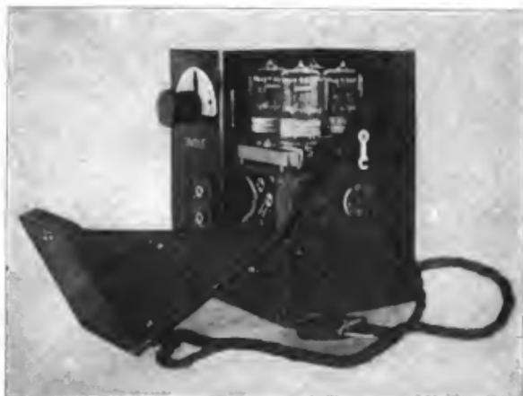
Abb. 179. Telefunken: Empfänger Type E. L. Größe: 15,3 - 11,5 - 18,2 cm. Gewicht: 3,02 kg.
