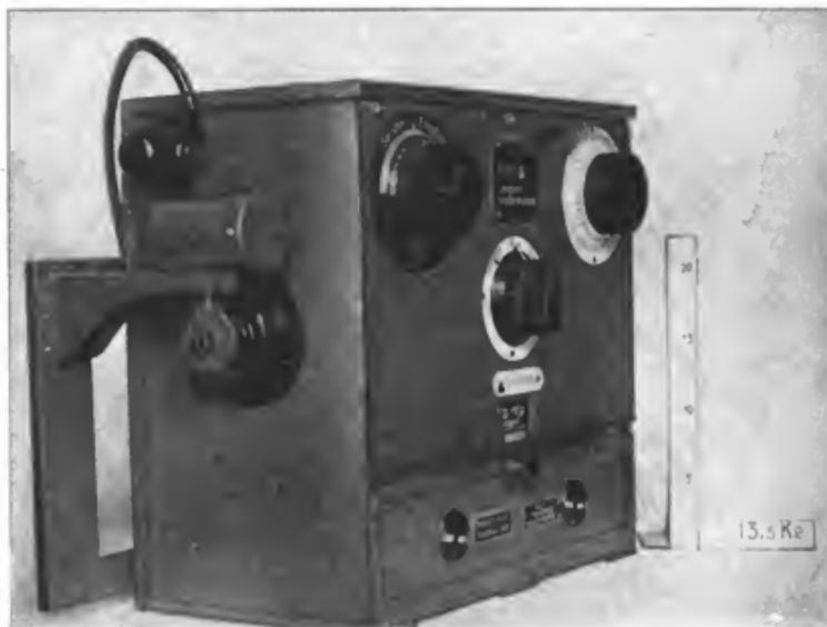
Abb. 229. Telefunken: Ungedämpfter Sende-Empfänger, Type USE I.
