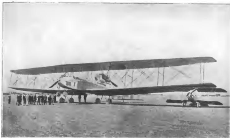
Abb. 9. Riesenflugzeug, Flugzeugbau Staaken, mit besonderer F.-T.-Kabine im Rumpf ausgerüstet.
