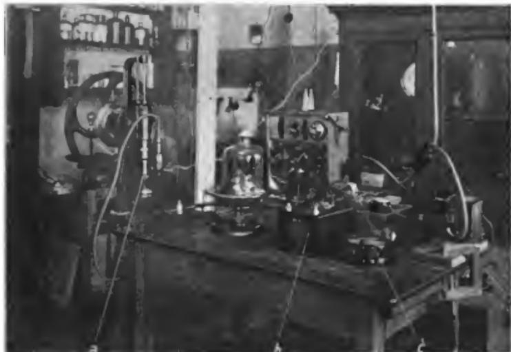
Abb. 304. Untersuchung der Funkenstrecke im Vakuum. a = Luftpumpe, b = Wellenmesser, c = Wattmeter, d = Ölkondensator.
