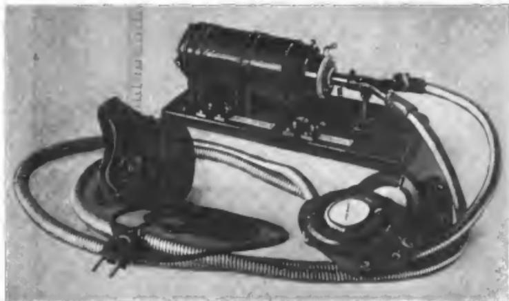
Abb. 128. Telegraphie-Ges. m. b. H., System Stille; Pneumatisches Relais mit Mikrophon und Flugzeug-Sprengerät der Firma Arnheim.
