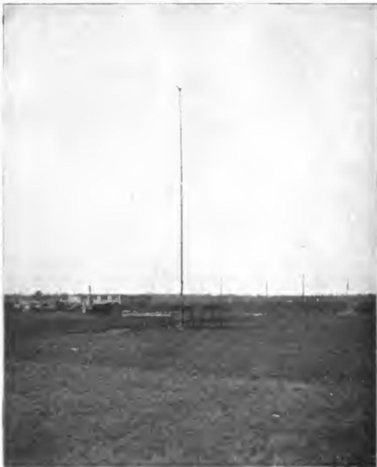
Abb. 248. Flieger-Gefechts-F.-T.-Station mit ausgekurbeltem 17 m Mast.
