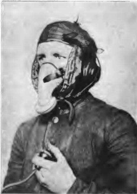
Abb. 343. Telefunken: Fliegerhaube mit eingebauten Kopfhörern und Sprechtrichter für drahtlose Telephonie.
