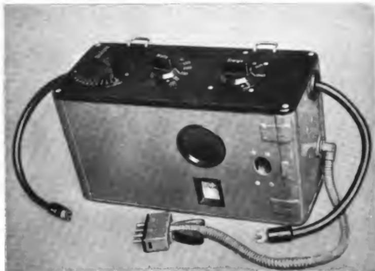
Abb. 157. Firma Dr. E. F. Huth: Einheitsflugzeug-Sendermodell 1914/15 mit galvanischer Koppelung.
